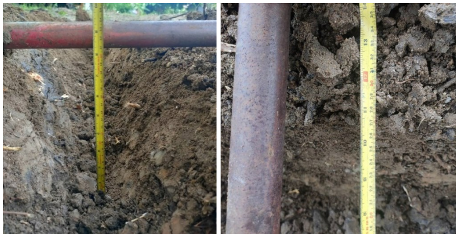
รูปภาพที่ 4.5 ขนาดของร่องขุดด้วยแรงคน
