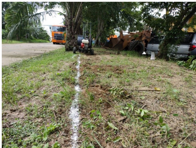
รูปภาพที่ 4.1 การขุดร่องด้วยเครื่องขุด
