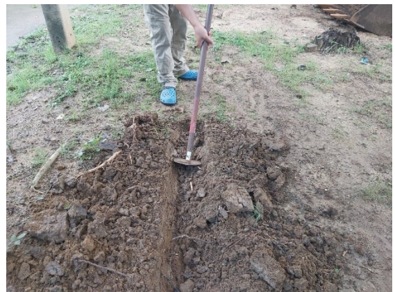
รูปภาพที่ ข.2 การทดสอบแรงงานคนโดยใช้จอบ
