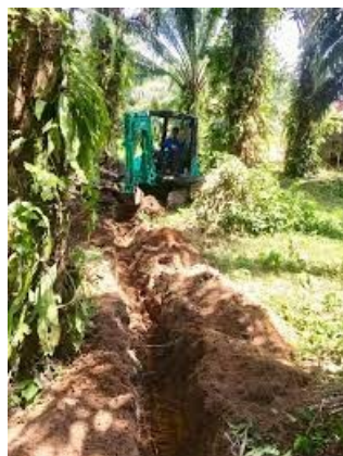
รูปภาพที่ 2.29 การขุดวางท่อเกษตรโดยใช้รถแบล็คโฮลเล็ก
