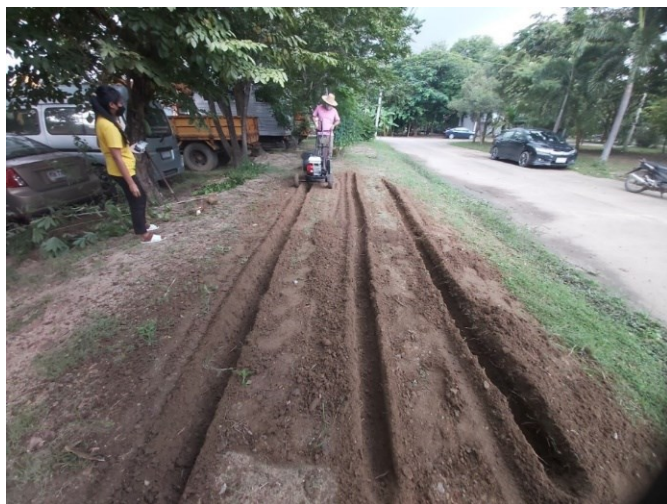
รูปภาพที่ 4.2 ลักษณะของร่องภายหลังจากการขุดด้วยเครื่องขุด
