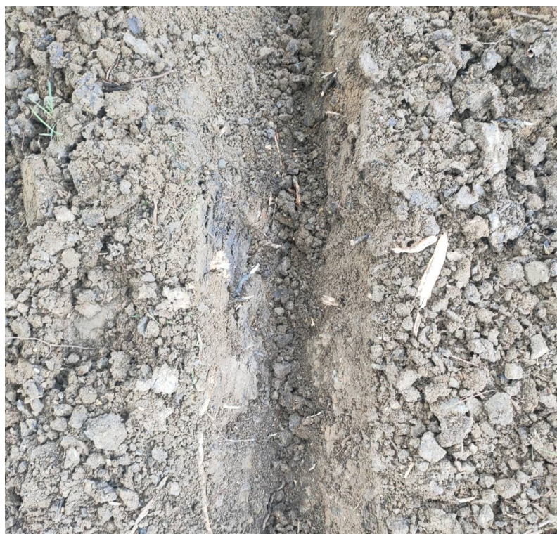
รูปภาพที่ 4.6 ลักษณะของร่องภายหลังจากการขุดด้วยแรงคน
