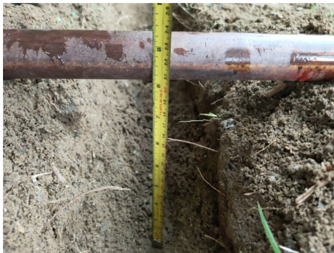
รูปภาพที่ 4.3 แสดงขนาดความลึกและความกว้างของร่อง
